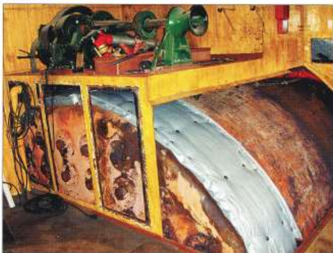
Under ångvinschen ligger ångpannan som vi här när delar av hatten avlägsnats. För att minska värmeförlusterna är ångpannan isolerad. En mindre del isolering ligger kvar över pannan. Foto Ove Ito 22 augusti 2008
